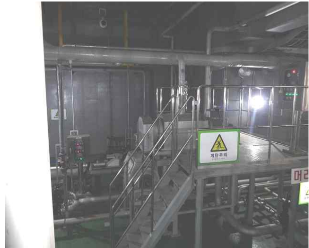
내부 상태 양호
